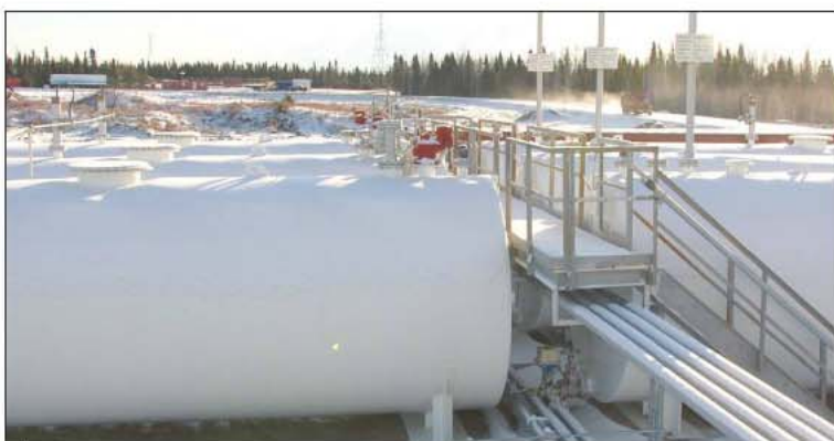
En arrière-cour, six énormes réservoirs, contenant 50 000 litres chacun, sont installés pour alimenter la flotte d'une dizaine de camions qui distribuent, chaque année, plus de 20 millions de litres dans la région.
